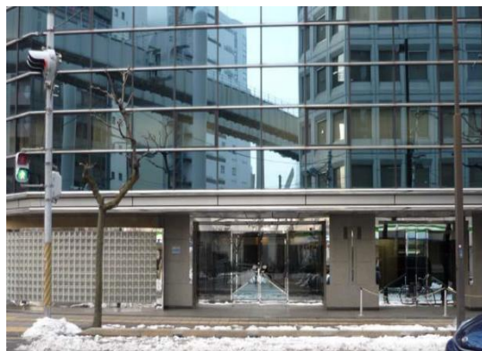
ビルエントランス
